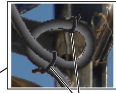
Kabelschleife und -binder Schleife mit Kabelbindern.
